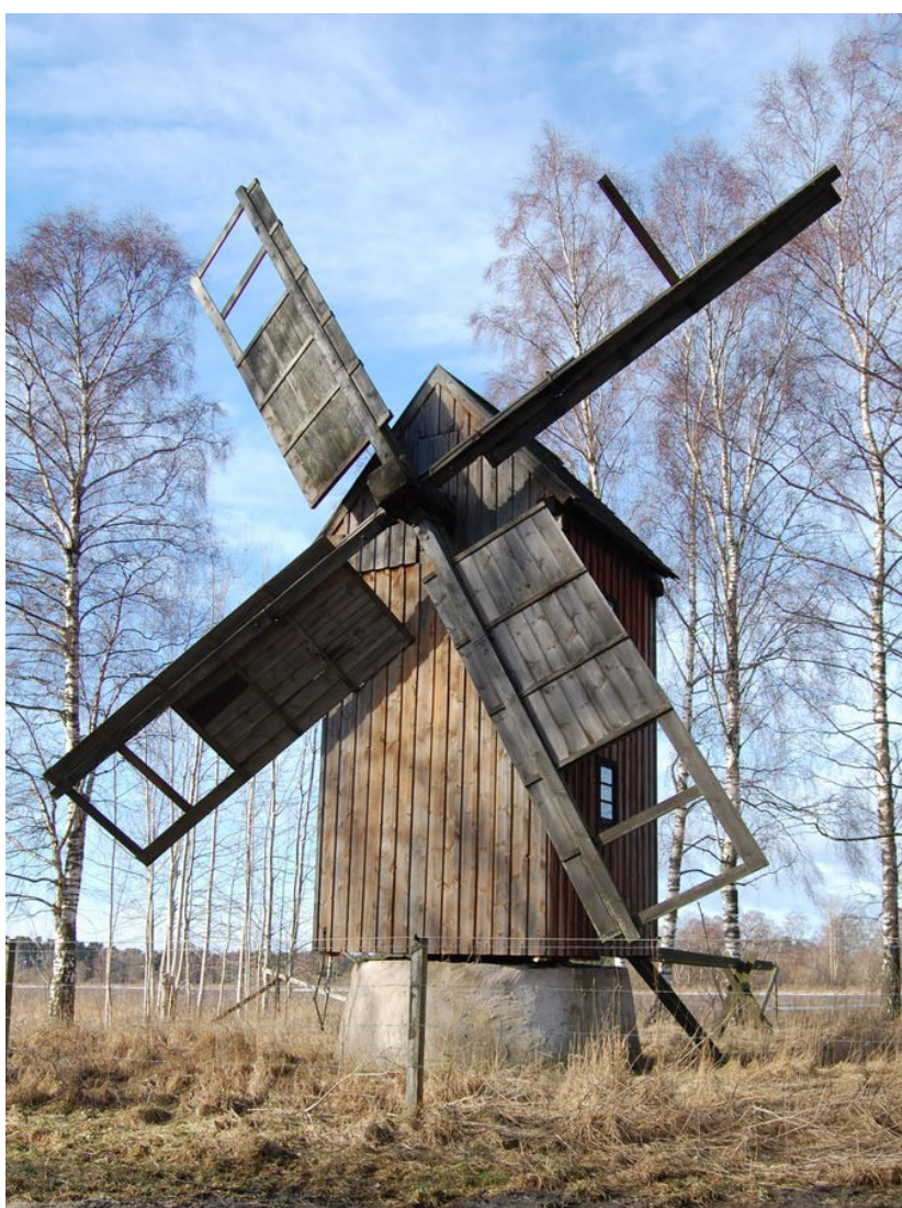
Botels (fd Fie) kvarn den 24 februari 2012. Två vingar är skadade.
