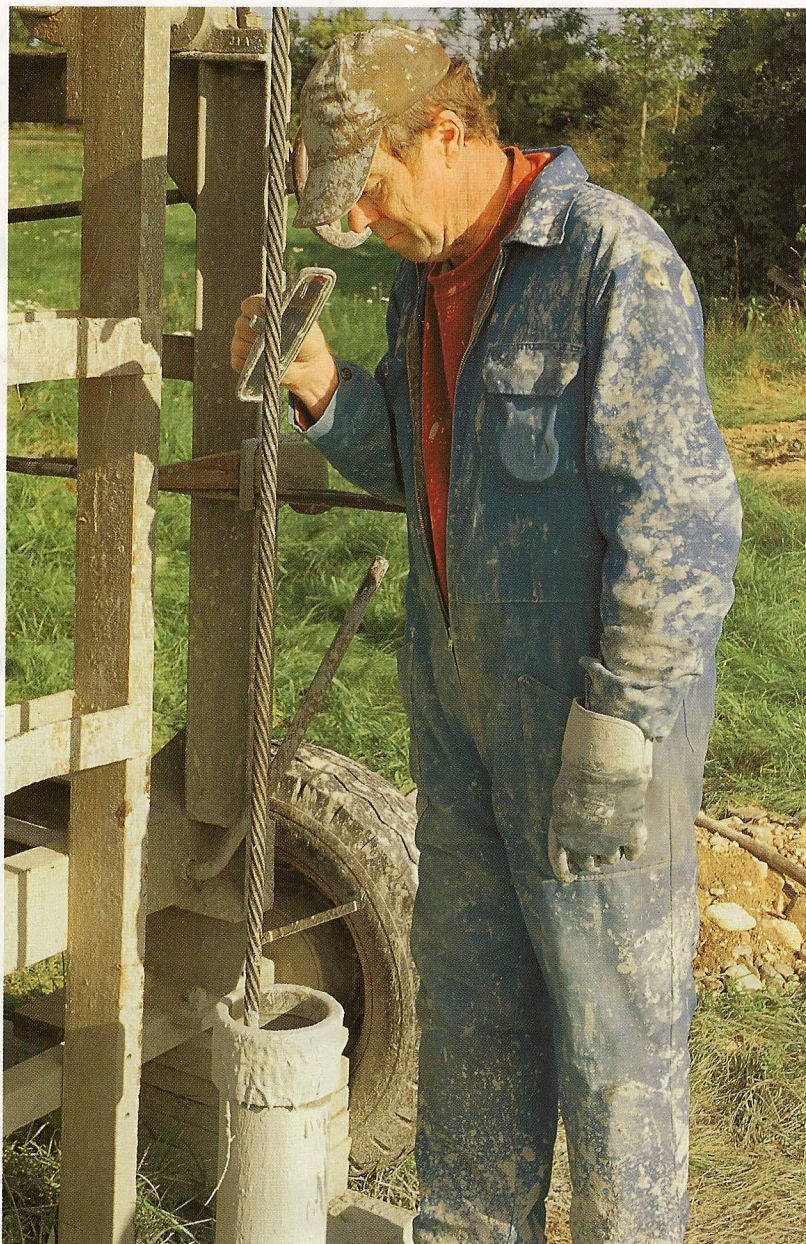
MED HJÄLP AV EN SPEGEL och solen lyser Bo upp borrhålet för kunna inspektera det under borringens gång.
